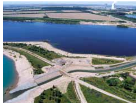
Vorflutanbindung des Hainer Sees an die Pleiße (ehem. Tagebau Witznitz), 2009 Anbindung des Hainer Sees an die Gebietsvorflut, 2009 Vorbereitende Maßnahmen für den Schleusenbau am Connewitzer Wehr, 2009
