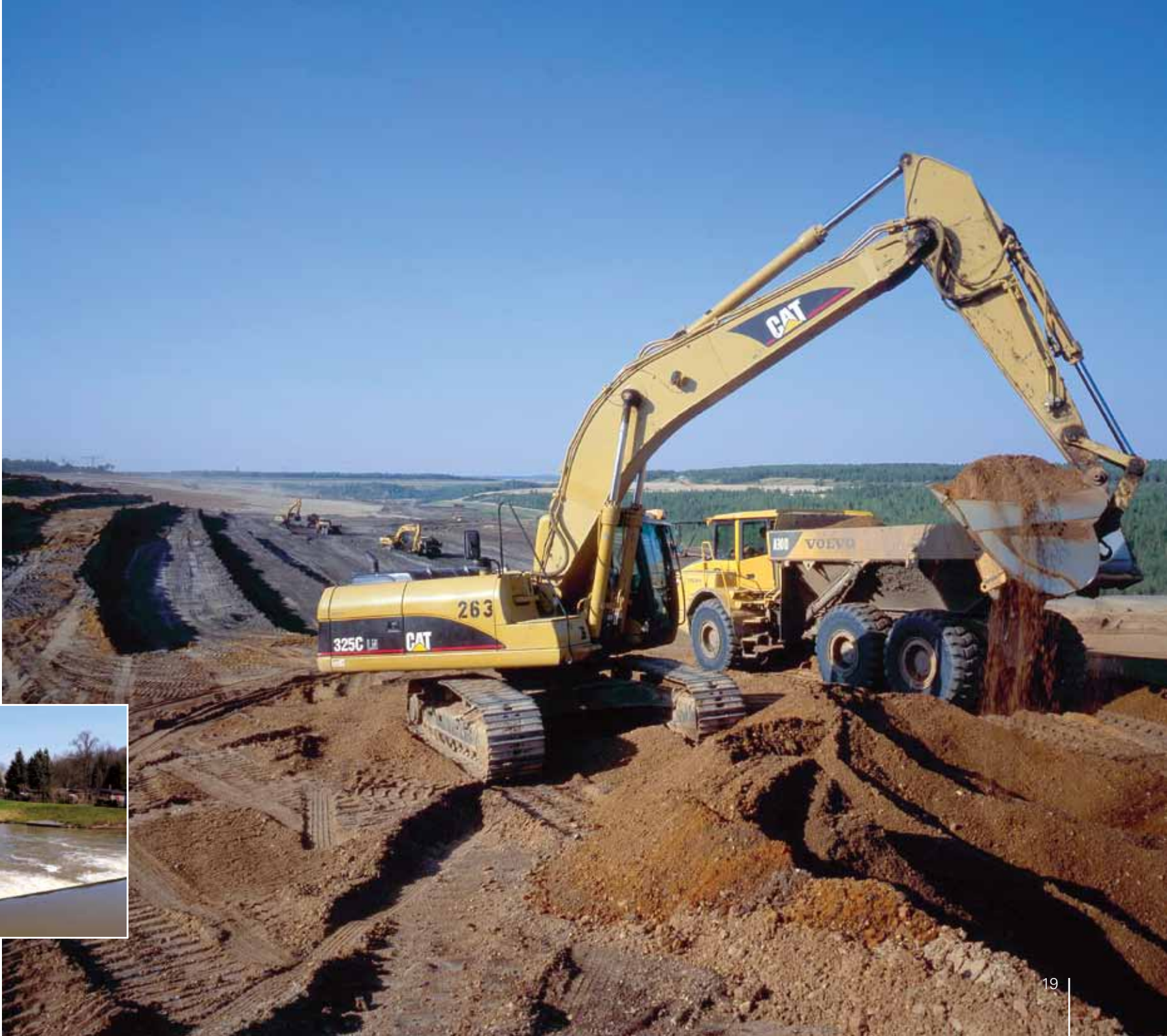
Sanierungsarbeiten am Ufer des Zwenkauer Sees, 2009
