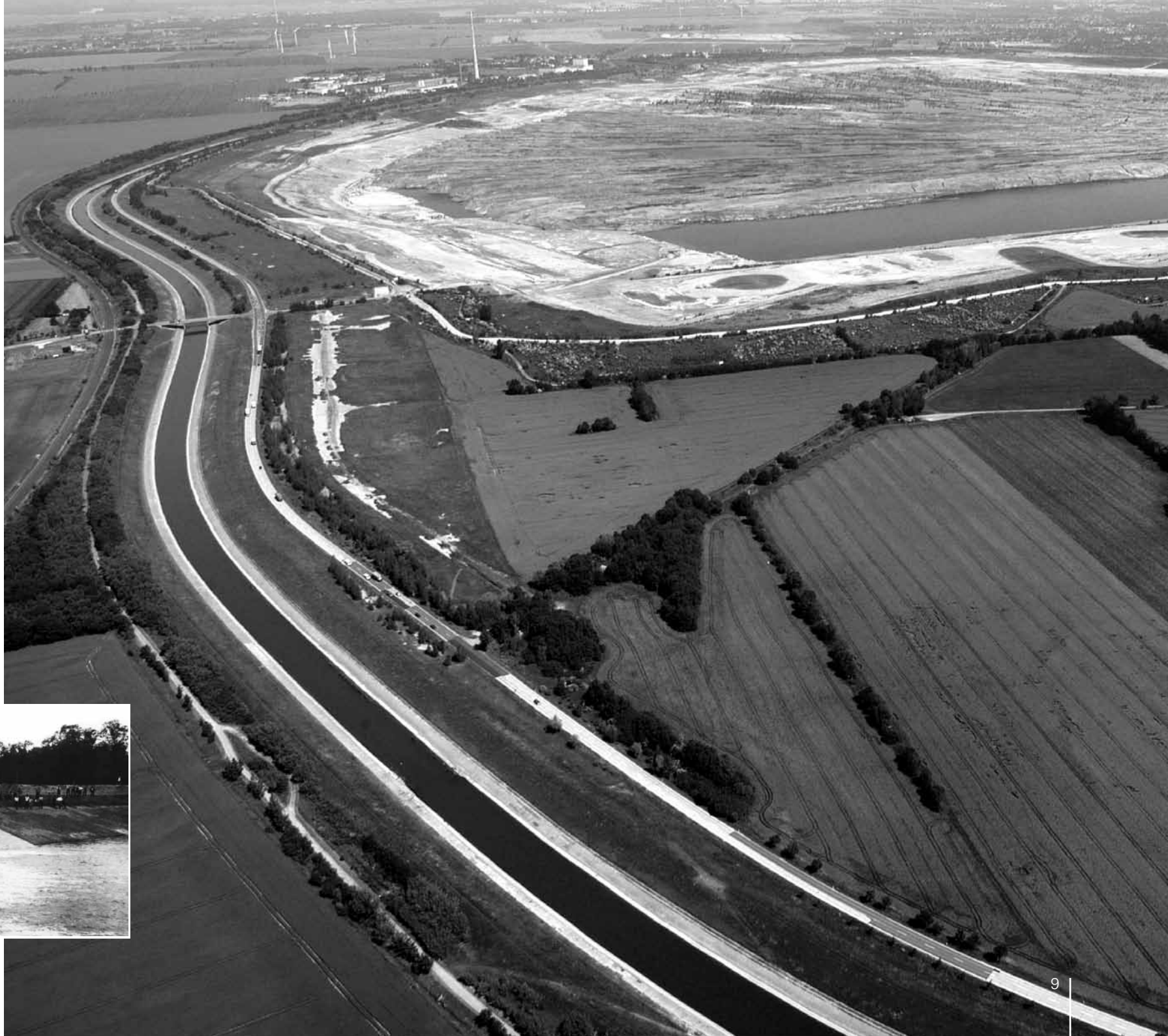
Betoniertes Bett der verlegten Weißen Elster westlich des ehemaligen Tagebaus Zwenkau (heute: entstehender Zwenkauer See), 2006
