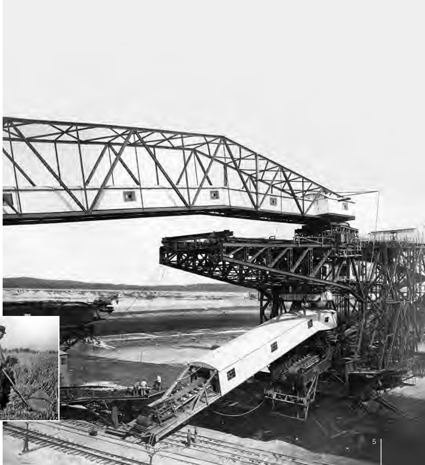
Aufbau der Abraumförderbrücke im Tagebau Friedländer, 1929
