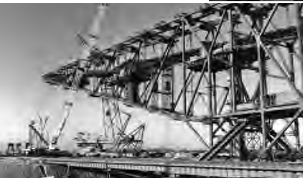
Aufbau der Abraumförderbrücke F60 im Tagebau Klettwitz-Nord, 1990
