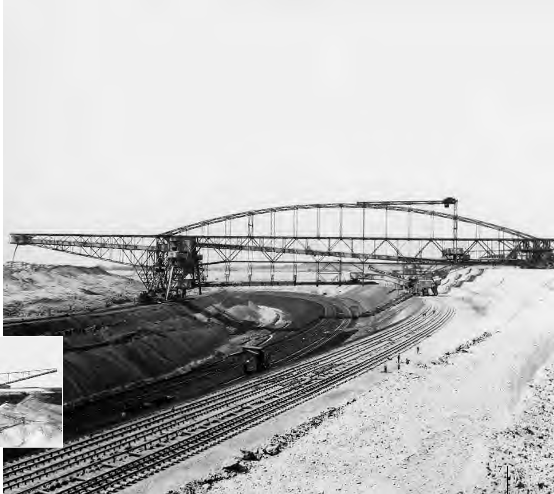
Förderbrücke Kleinleipisch der BUBIAG nach dem Umbau mit verstärkendem Rundbogen, 1938
