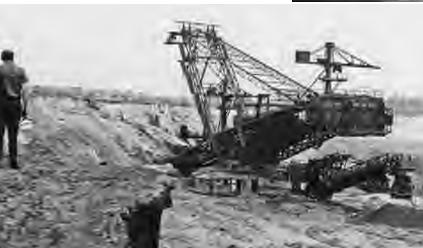
Von Altkippenrutschung eingeschlossener Bagger SRs 1200-131, 1970
