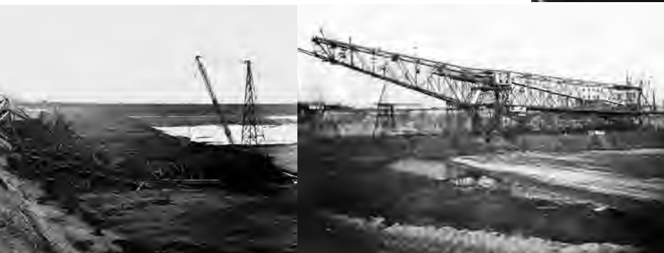
Während der Bauphase eingestürzte Förderbrücke im Tagebau Friedländer, 1929 Abraumförderbrücke „Friedländer“ (ab 1940 „Karl-Büren-Grube“) der BUBIAG in der Montagephase im Tagebau Friedländer, März 1929
