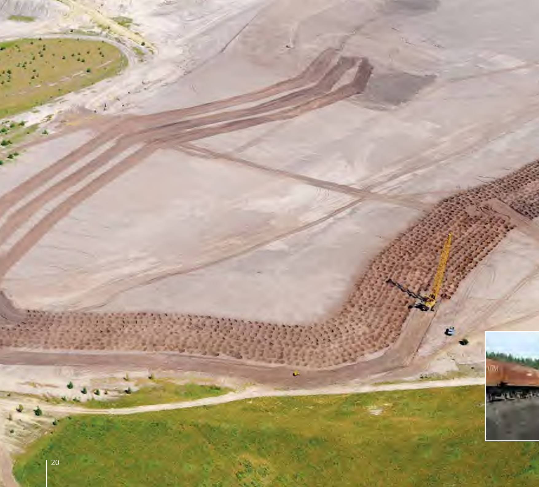
Fallgewichtsverdichtung im Bereich der „Schwarzen Keute“ im ehemaligen Tagebau Klettwitz, 2010
