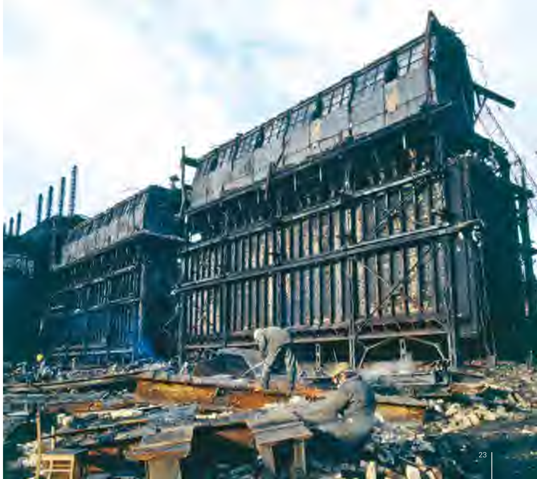
Abriss der Kokerei Lauchhammer, 1993
