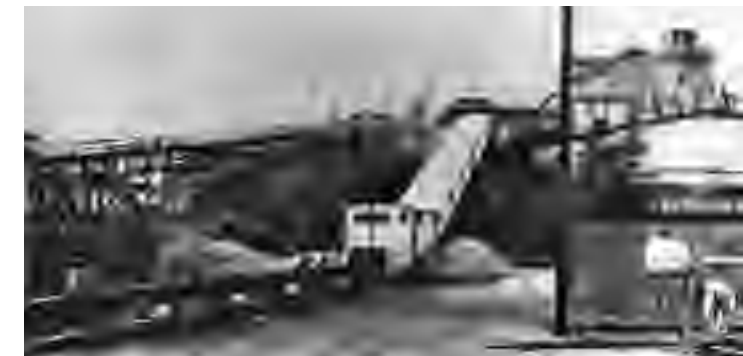
Grabenbunker der Brikettfabrik 68 nach Inbetriebnahme, 1938 Investitionsruine Industriekraftwerk Lauchhammer, um 1995
