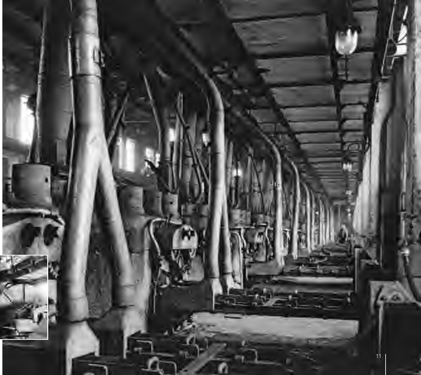
Brikettpressen in einer der vielen Brikettfabriken in Lauchhammer, um 1953
