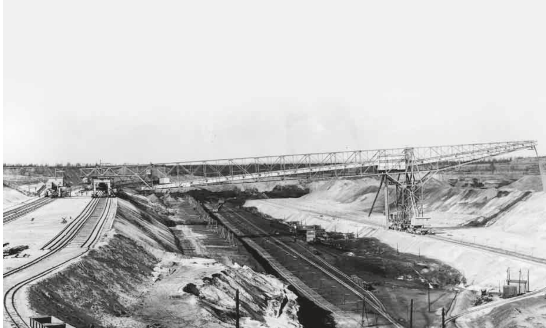
Abraumförderbrücke AFB 30 (ATG 13) im Tagebau Bergwitz, 1932
