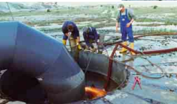
Monteure bei der Vorbereitung des Probebetriebs am Auslauf der Flutungsleitung, 1999
