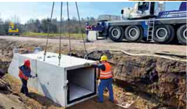
Bau eines Durchlasses am Joesigk-Breitewitzer Bach, 2014
