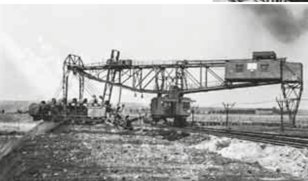
Eimerkettenbagger im Tagebau Bergwitz, um 1920
