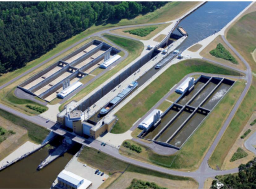
Die Doppelsparschleuse Hohenwarthe ermöglicht der Schifffahrt den direkten Auf- und Abstieg zwischen dem Mittellandkanal und dem Elbe-Havel-Kanal.
