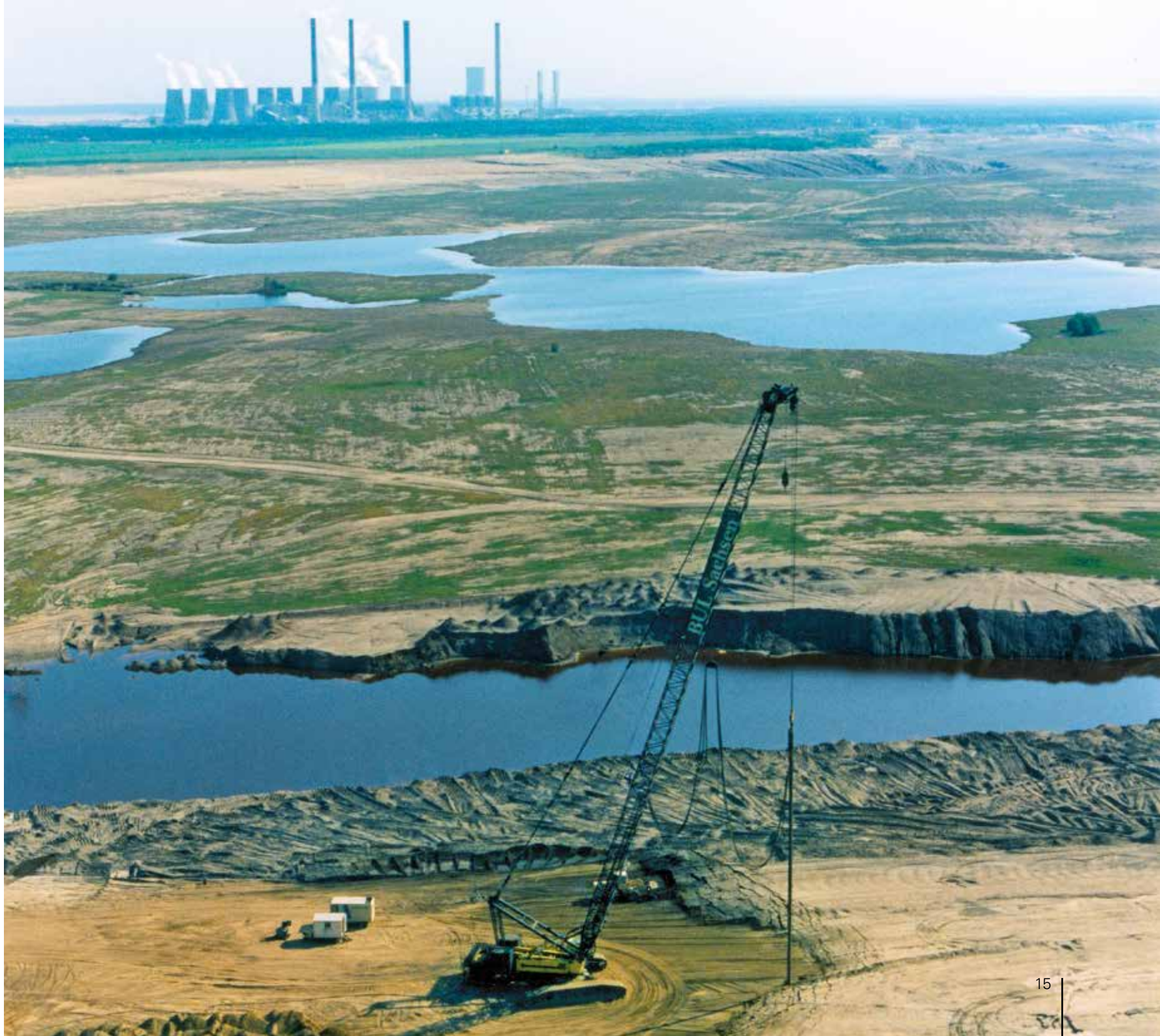
Rütteldruckverdichtung im Uferbereich von Uhyst im stillgelegten Tagebau Bärwalde, 1997
