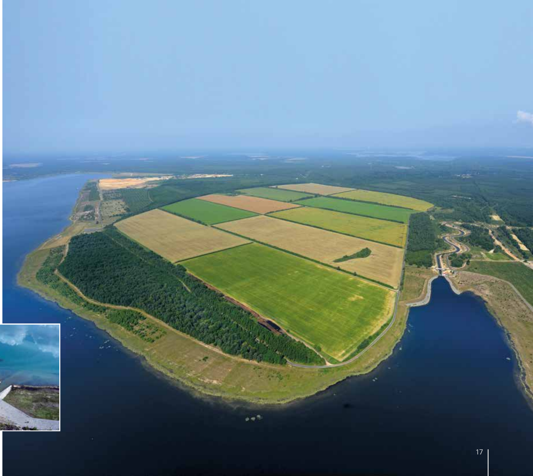
Bärwalder See mit Auslaufbauwerk, 2013
