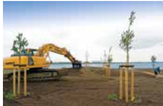
Erdbau- und Pflanzarbeiten am Südufer des Bärwalder Sees, 2011
