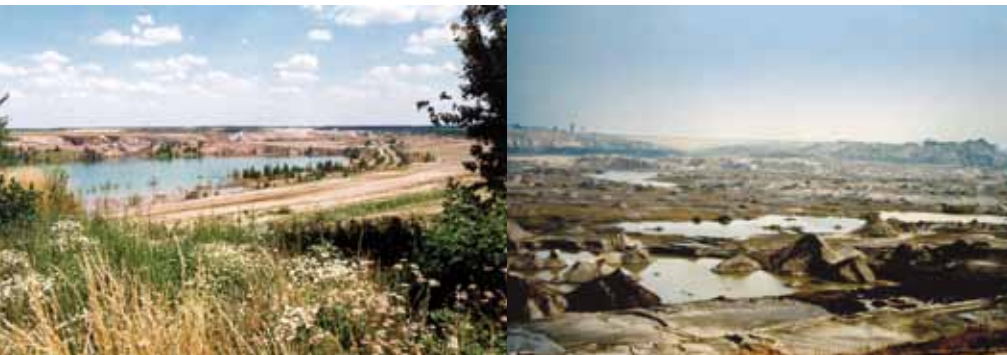
Sanierungsarbeiten im Restloch Cospuden, 1996 Teilweise geflutetes Restloch Cospuden, um 1996 Restloch Cospuden, 1993
