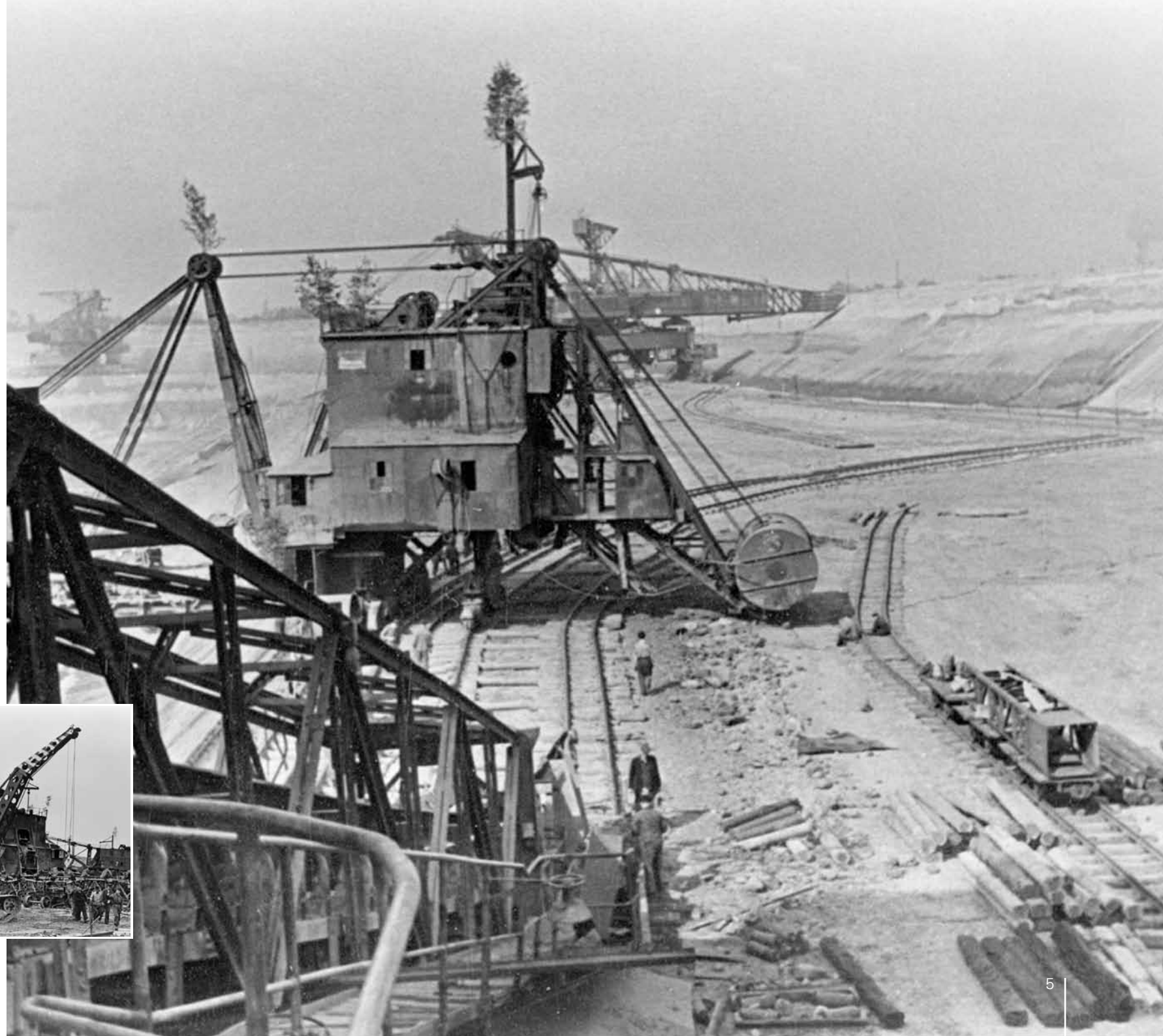
Aufschlussbaggerung im Tagebau Böhlen, um 1921
