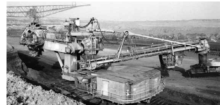
Bagger 1529 im Tagebau Zwenkau, im Hintergrund: die stillgelegte AFB Böhlen II, 1999 Gesprengte Abraumförderbrücke Böhlen II, 2001
