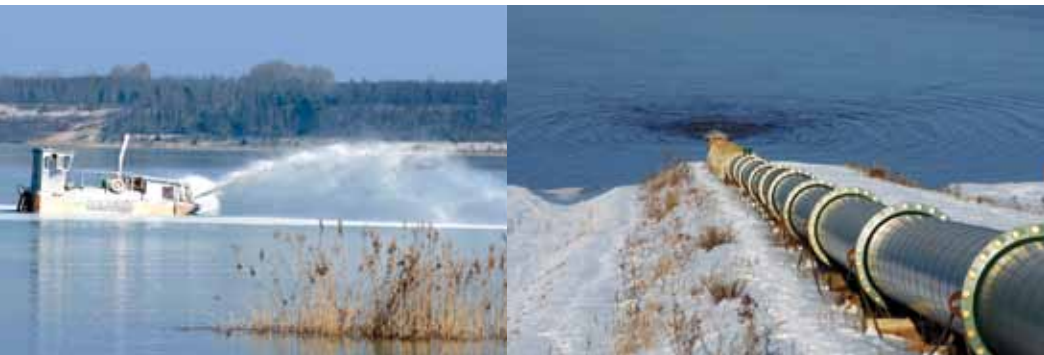
Beginn der Fremdflutung, 2007 Sanierungsschiff auf dem Haselbacher See, 2009 Flutungsleitung zum Zwenkauer See, 2009
