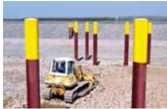
Errichtung des Hafenbeckens Zwenkau, 2009
