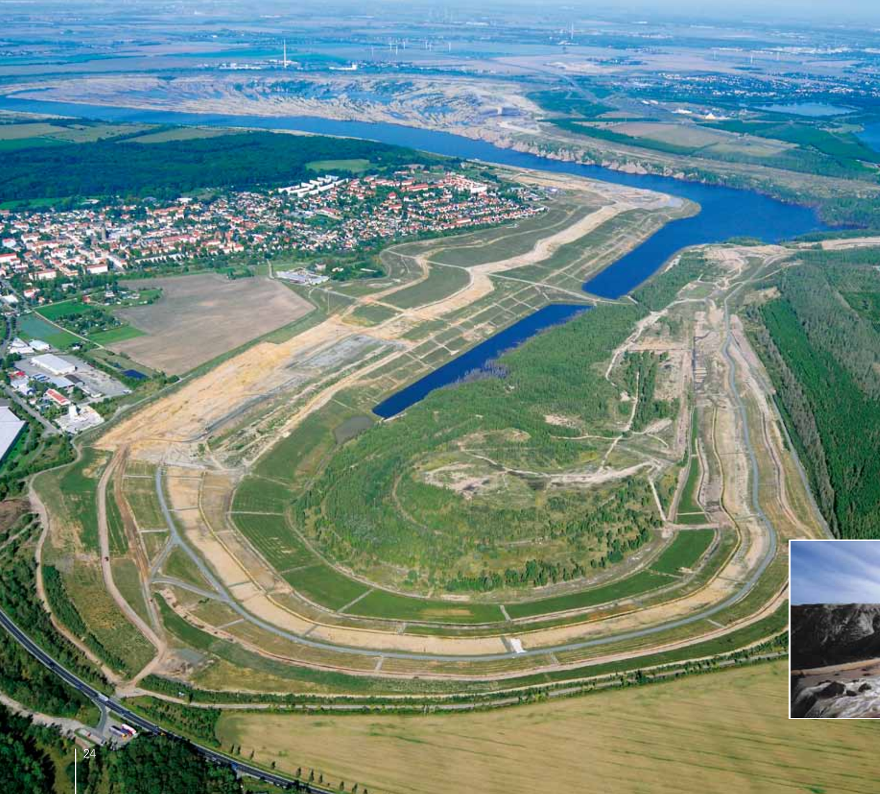
Blick über das sanierte und teilweise geflutete Tagebaurestloch Zwenkau, 2008
