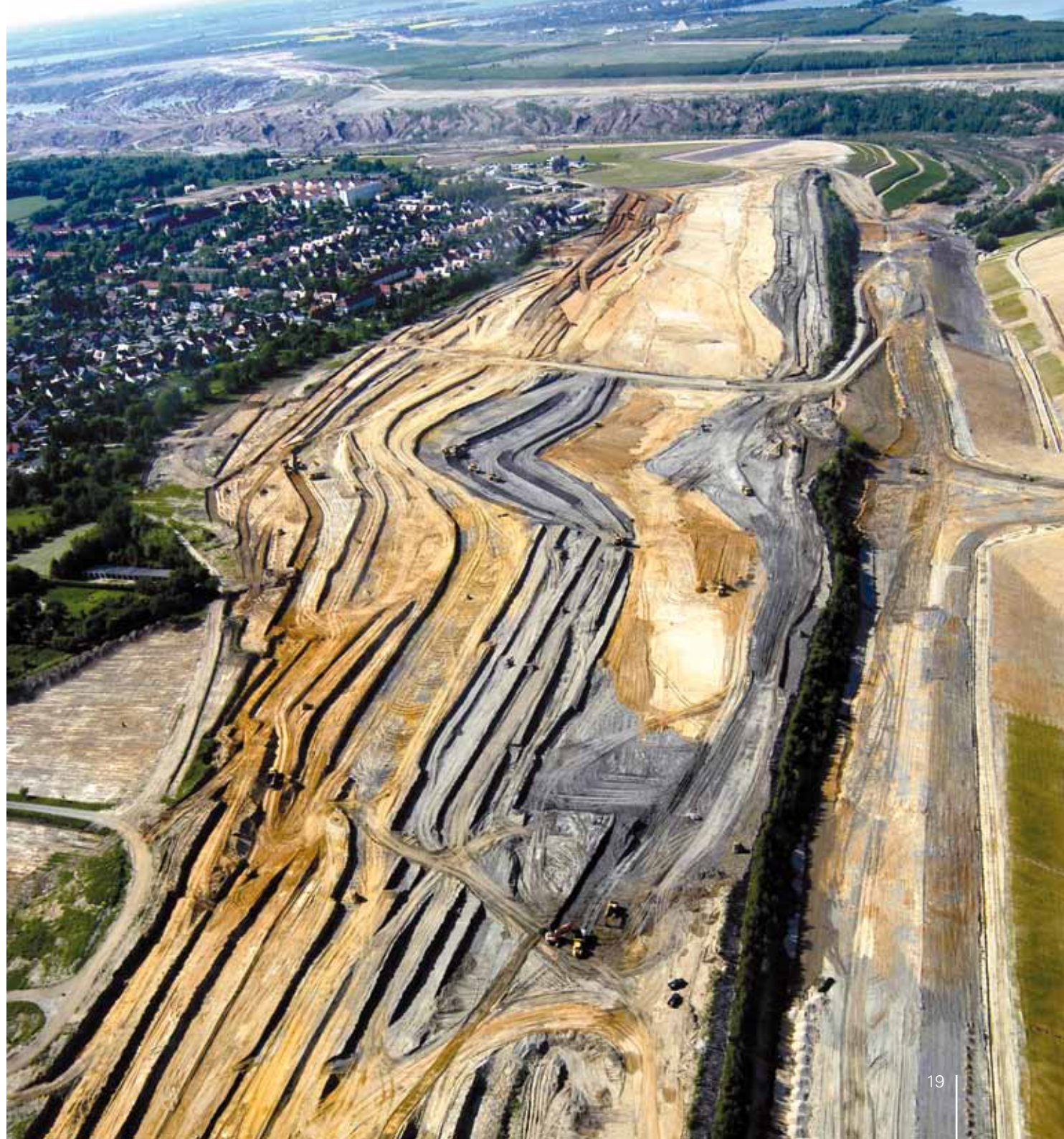
Sicherung der Uferböschungen des künftigen Zwenkauer Sees, 2005
