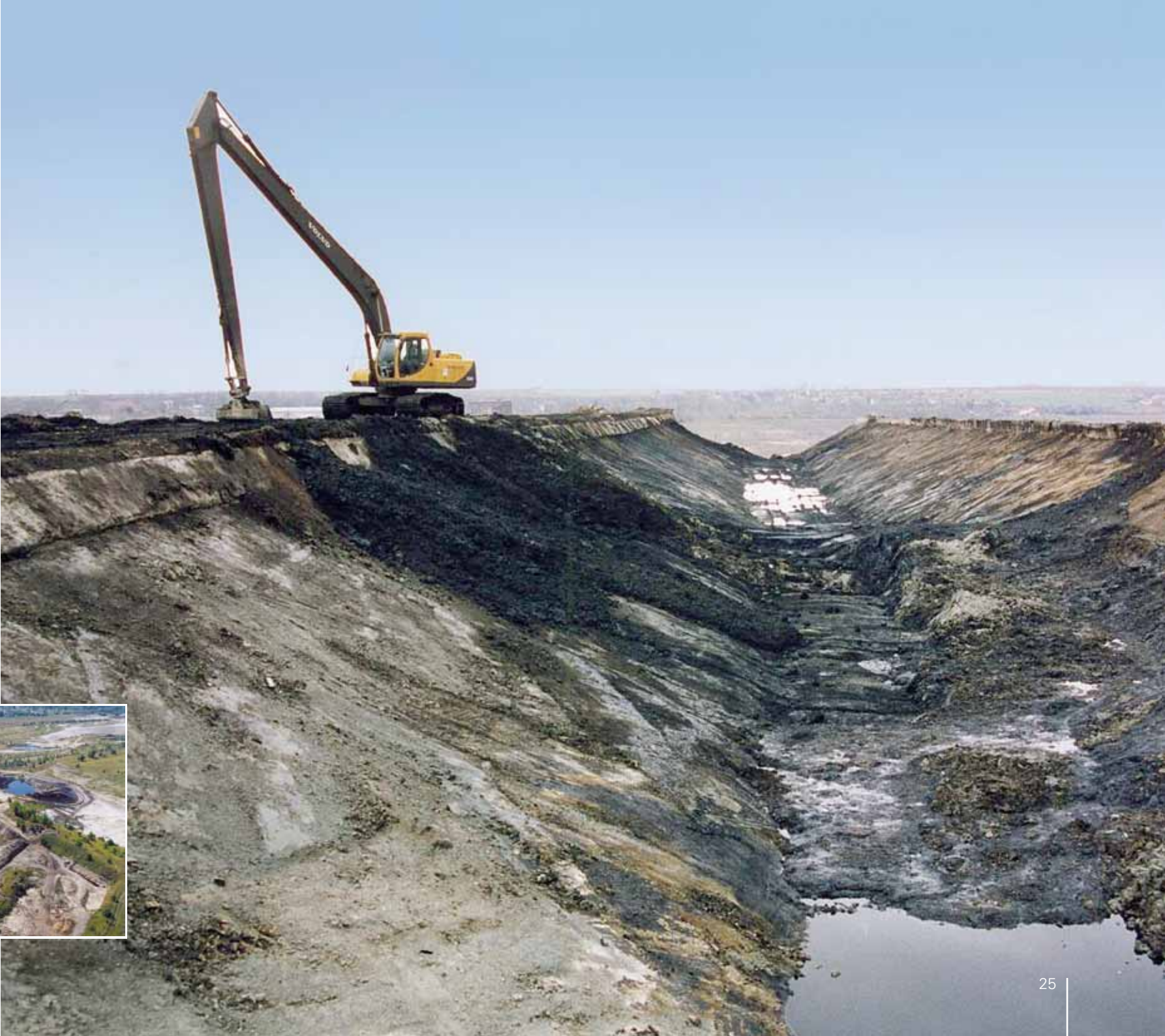
Sanierung der Säureharzbecken auf der Innenkippe Leonhardt im Restloch Mücheln, 2002
