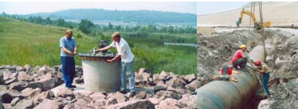
Einweihung des neuen Einlaufbauwerkes Geisel, 2009 Bau der Flutungsstelle für das Restloch Braunsbedra bei Frankleben, 2002 Bau der Flutungsleitung, 2002
