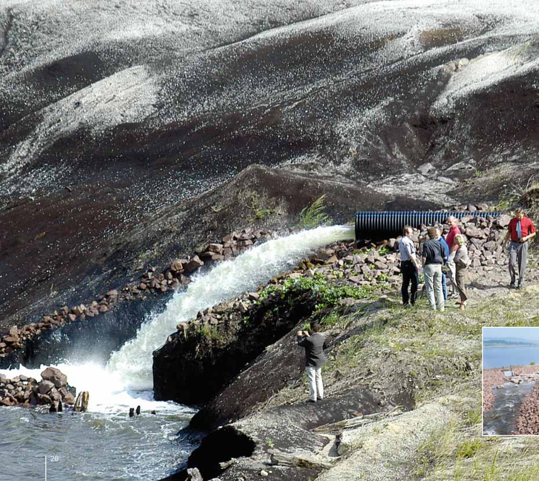
Überlaufbauwerk vom Restloch Braunsbedra zum Südfeld, 2006
