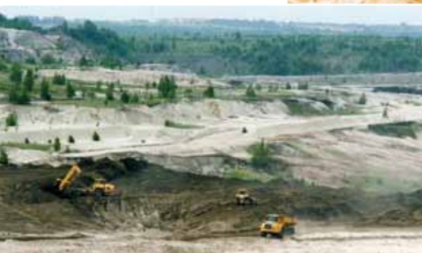
Restloch Mücheln während der Sanierung, 1998 Sanierungsarbeiten im Tagebau Mücheln, 2002
