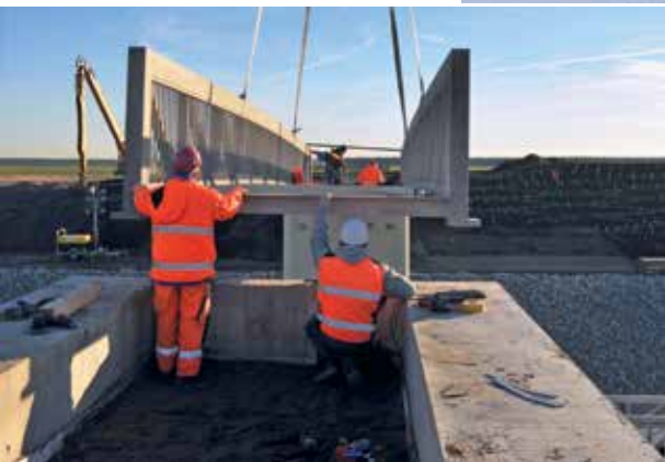
Erdarbeiten am Überleiter 11, 2013 Montage der Radwegbrücke über den Überleiter 11 am Sedlitzer See, 2013
