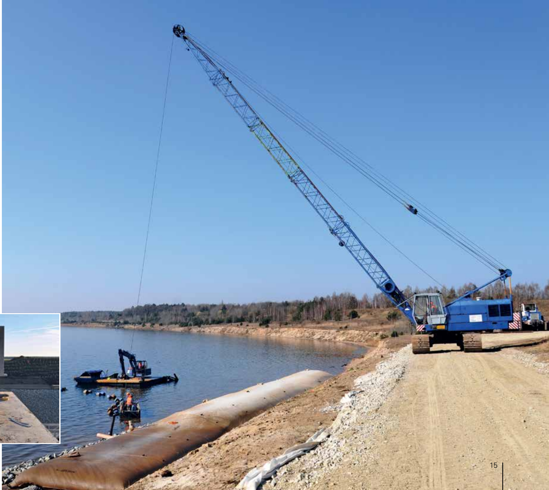
Kliffsicherung mit Geotubes bei Lieske am Sedlitzer See, 2014
