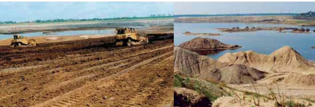
Paupitzscher See, 2005 Böschungsstabilisierung mit Planier- technik am Restloch Mühlbeck, 1997 Blick über das Tagebaurestloch Mühlbeck, 1999
