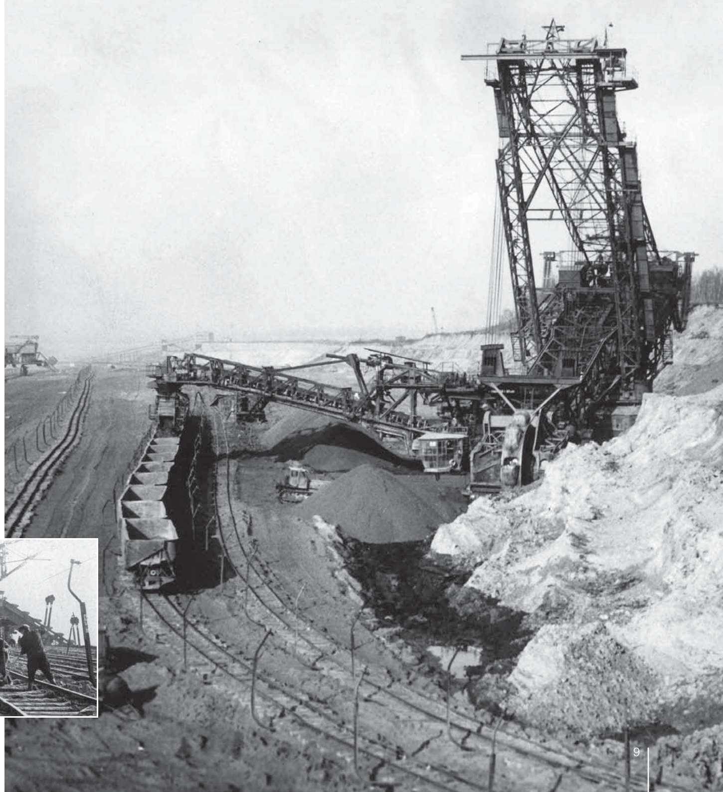
Schaufelradbagger 1401 SRs 1200 bei der Baggerung am Schwenkende im Tagebau Holzweißig, um 1970
