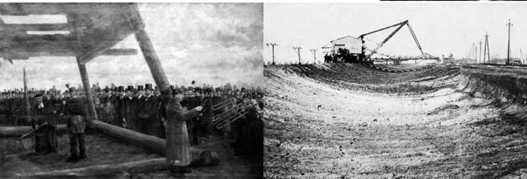
Legen des ersten Schachtgeviertes der Grube Margaretha zu Espenhain, 1898 Eimerkettenbagger bei der Aufschlussbaggerung, 1937
