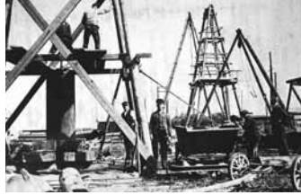
Herstellung des Fluchtschachtes für den Tagebau Espenhain, 1938
