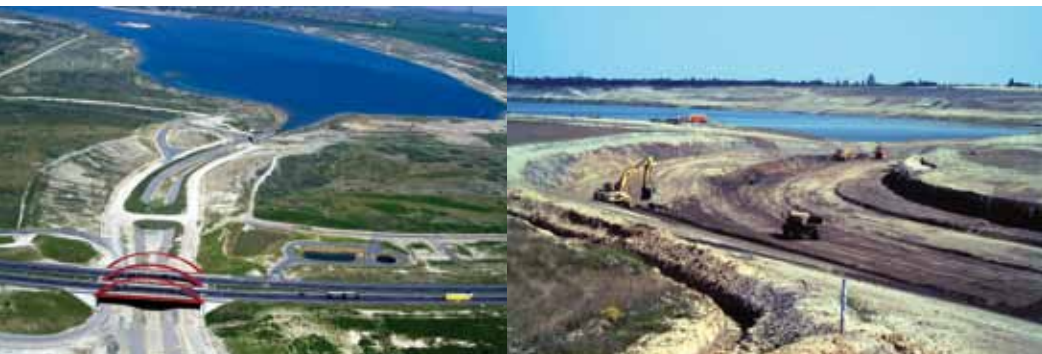
Mit dem Kommando „Wasser marsch!“ begann die Flutung des Störmthaler Sees, 2003
