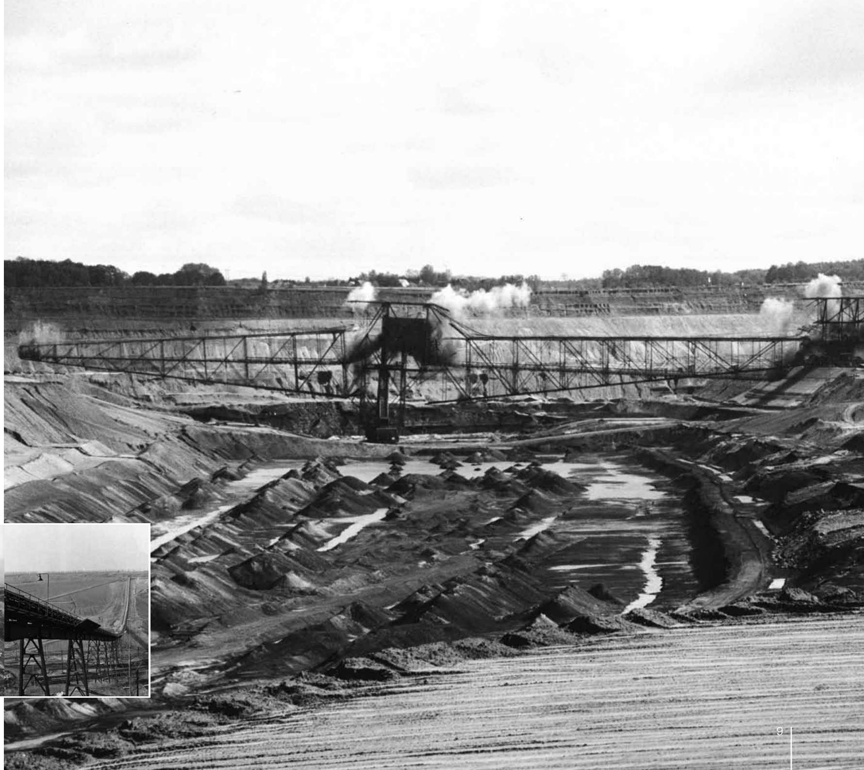
Sprengung der Abraumförderbrücke AFB 17, 1997
