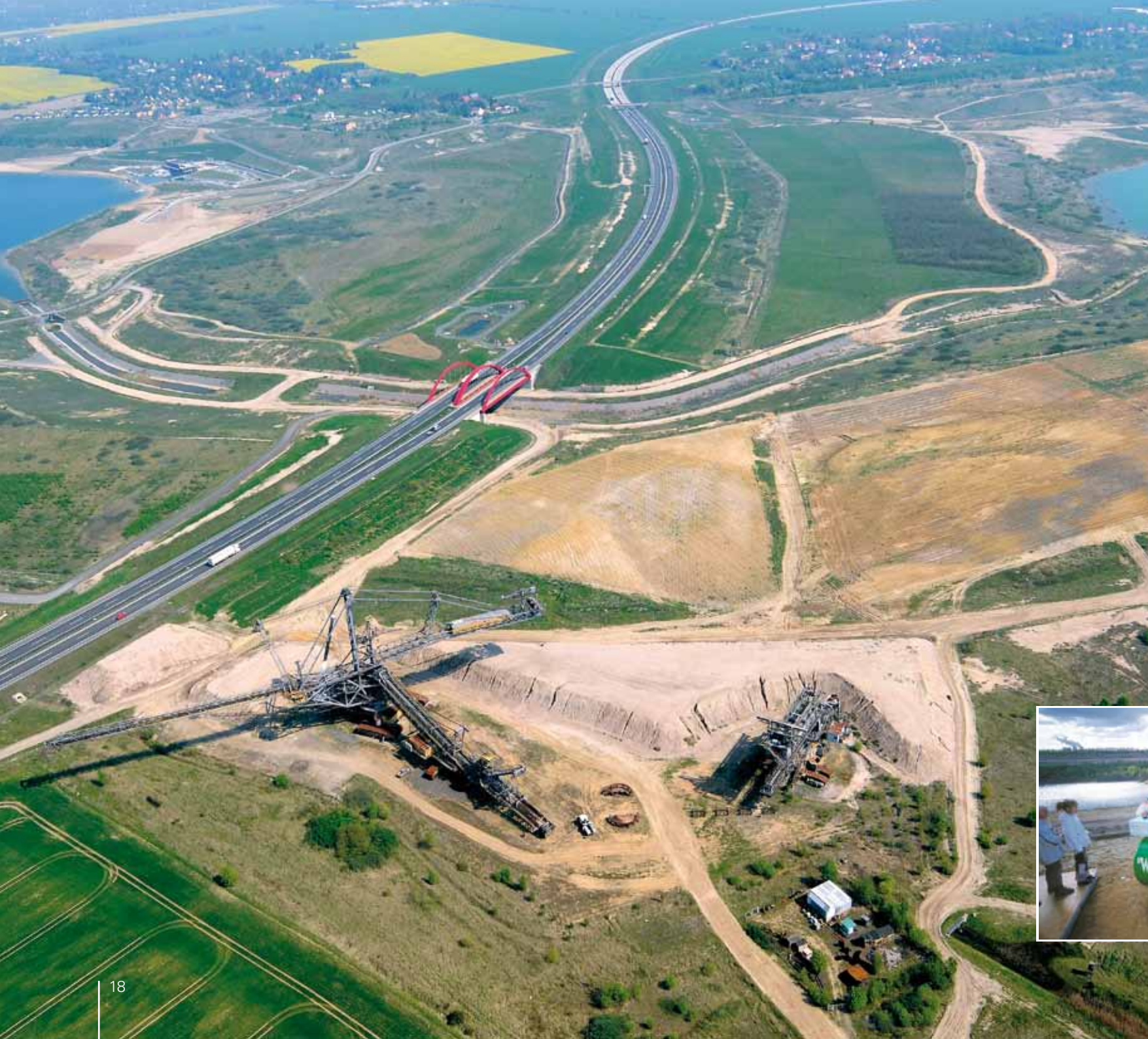
Entstehende Gewässerbindung zwischen Störnthaler und Markkleberger See, 2009
