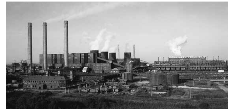
Das Braunkohlenwerk Espenhain, 1995 Schaltwarte des Kraftwerkes Espenhain, 1954 Bau des Fundamentes für den Schornstein des Kraftwerkes I, 1939
