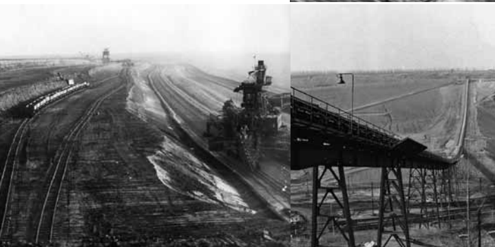
Umstellung des Vorschritts von Zug- auf Bandförderung, 1985 Förderbandanlage im Tagebau Espenhain, um 1985
