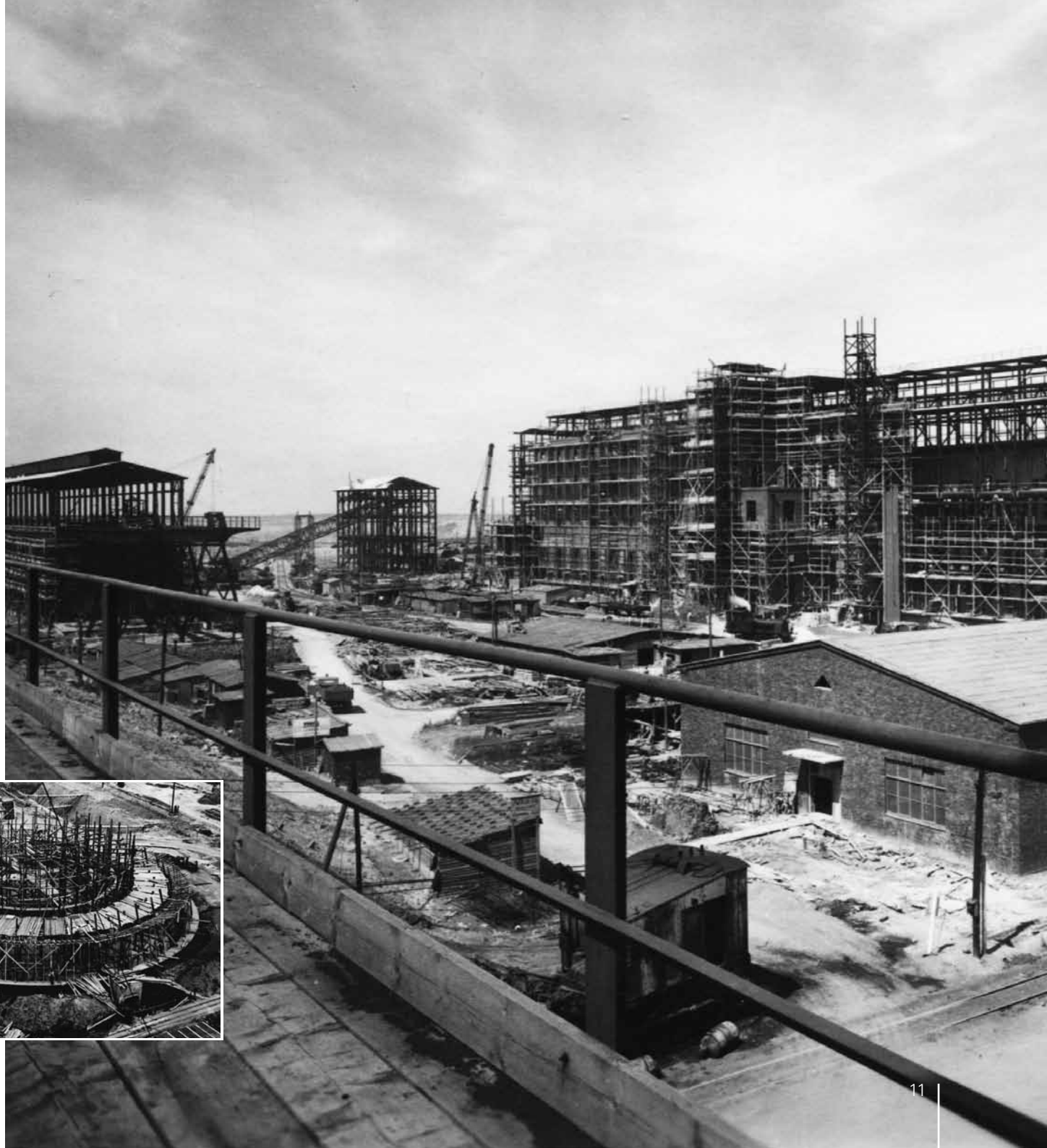
Aufbau des Trockenofens und des Pressenhauses für das Braunkohlenwerk Espenhain, 1940
