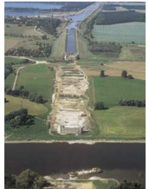
Abbruch der alten Vorlandbrücken-Bögen
