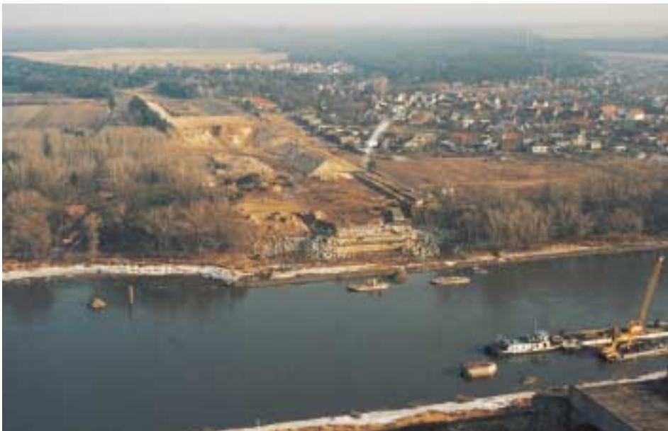
Sprengung / Abbruch Widertager Ost
