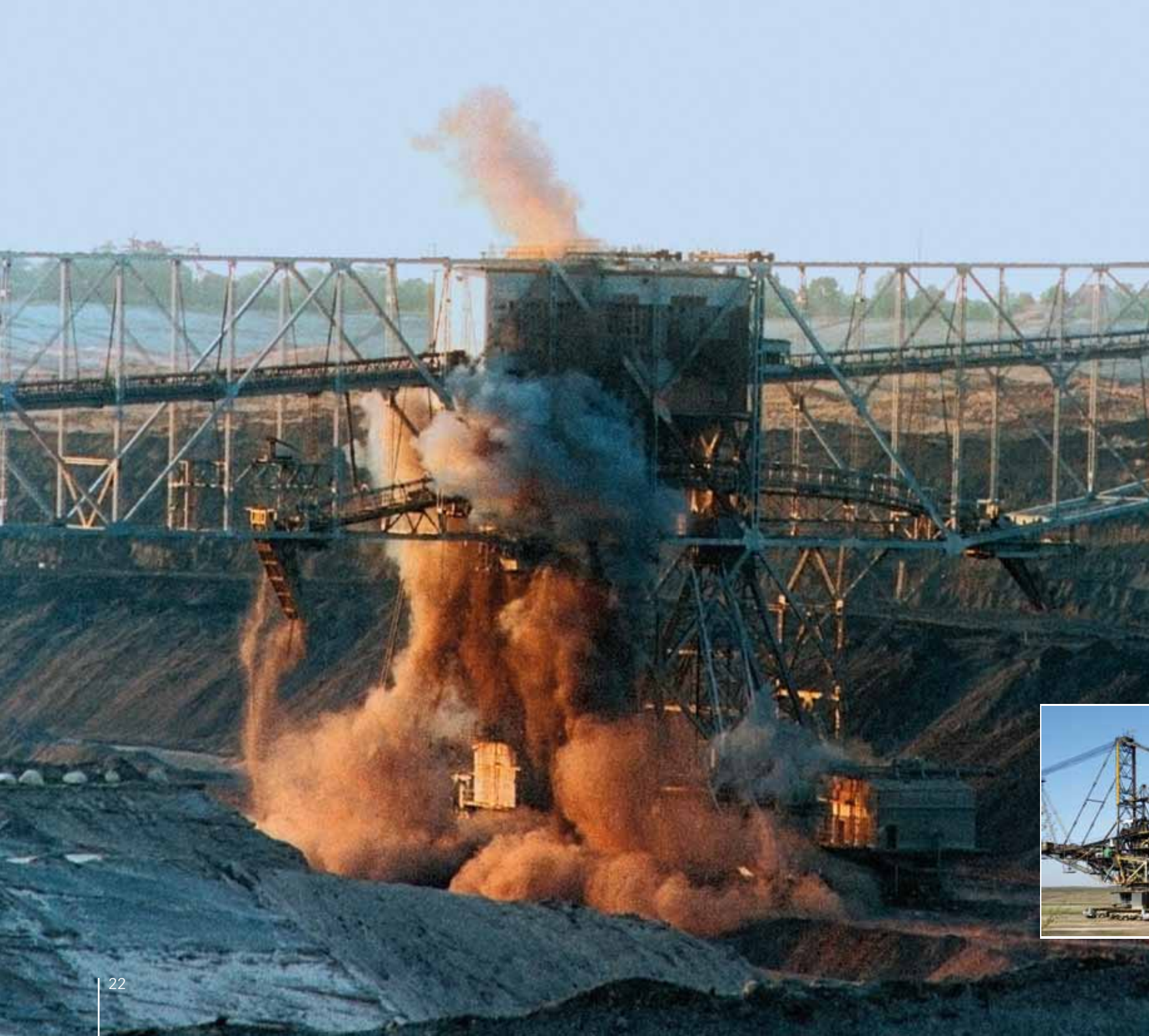
Sprengung der Abraumförderbrücke F 45 im Tagebau Meuro, 2000
