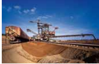
Restlochschließung mit einem Absetzer, 2001
