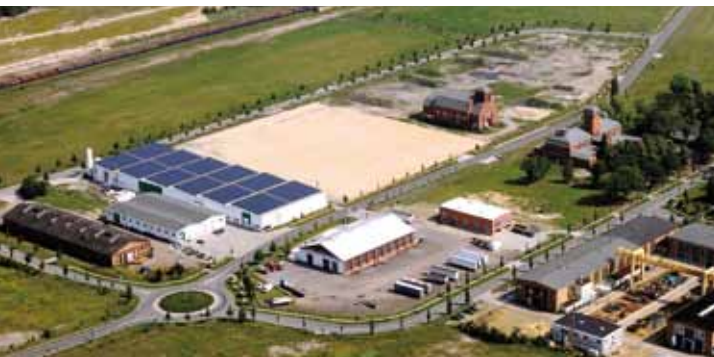
Sonnenkollektoren in einem Solarpark Produktionsstandort des Solarmodulherstellers EPV Solar in Brieske, 2009
