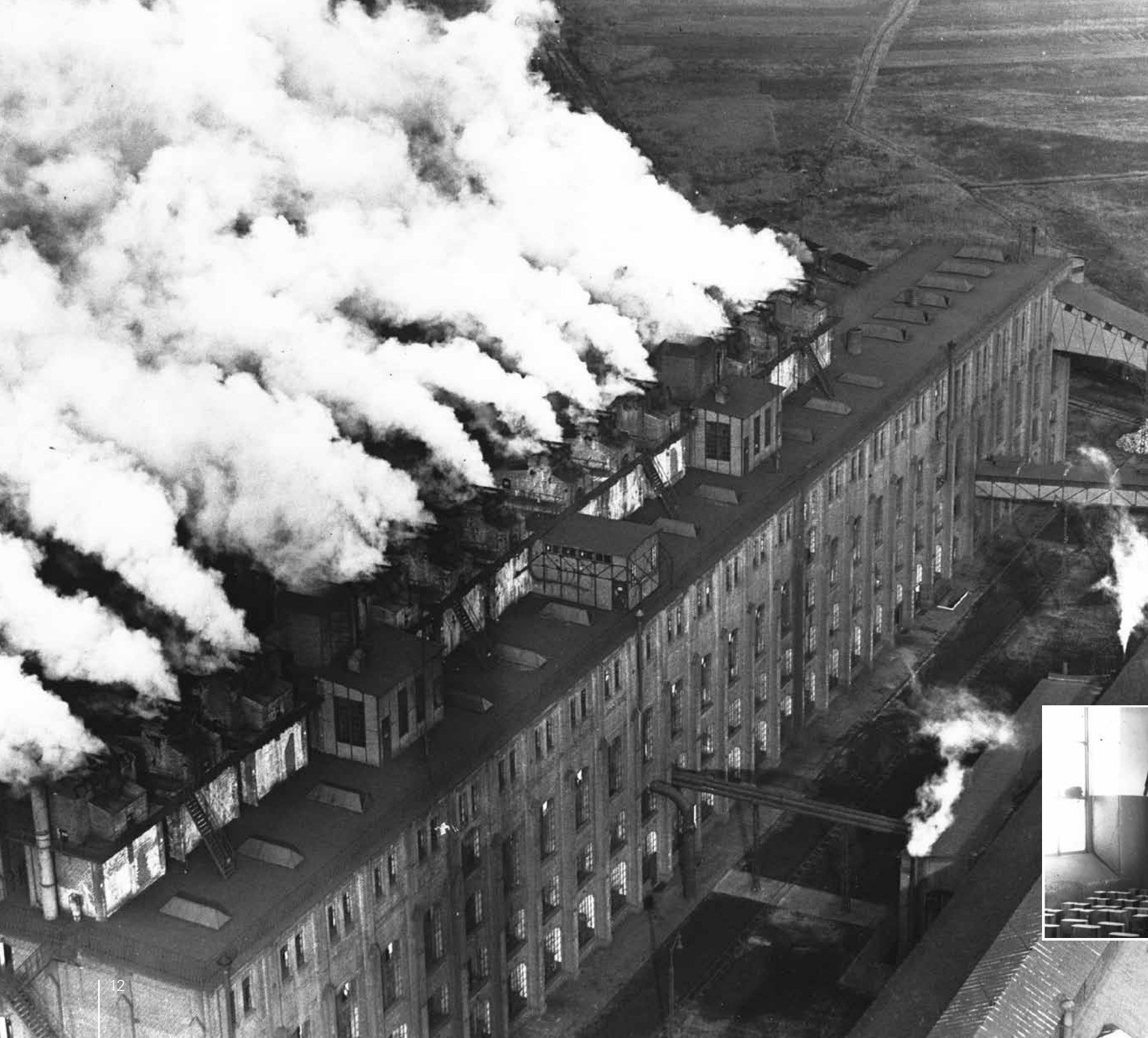
Dampfende Brüdenschlote der Brikettfabrik Marga, 1932
