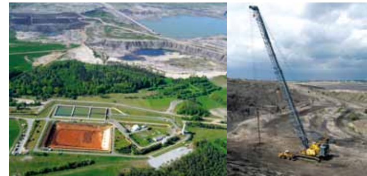
Grubenwasserreinigungsanlage Rainitza, 2008 Rütteldruckverdichtung im Tagebau Meuro, 2005 „Wasser marsch!“ im Tagebau Meuro, 2007
