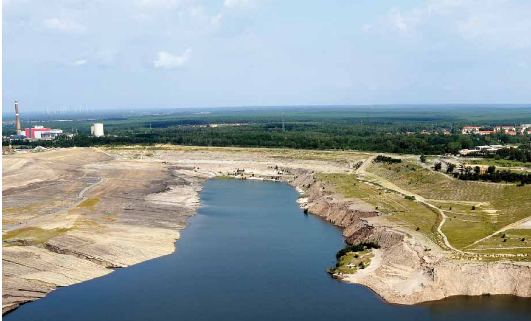
Blick auf den entstehenden Ilse-See, links im Bild: das Ersatzbrennstoff- kraftwerk am Standort Sonne, rechts: die Stadt Großräschen, 2009
